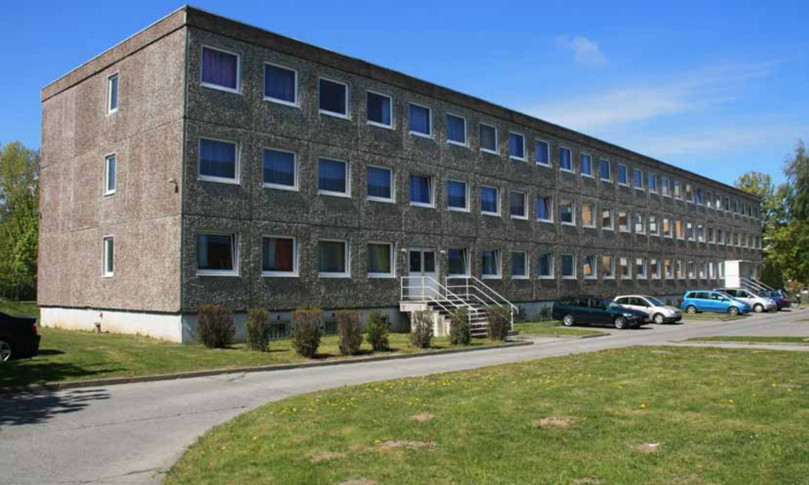
Links: Neuanfang auf engstem Raum – Zimmer einer iranischen Familie Rechts: In Beton gegossene Funktionalität – Asylbewerberheim in Greifswald
